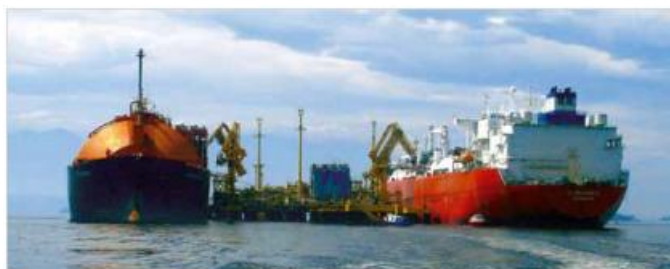
Figura 3: Terminal Aquaviário de LNG da Baía de Guanabara (RJ)
